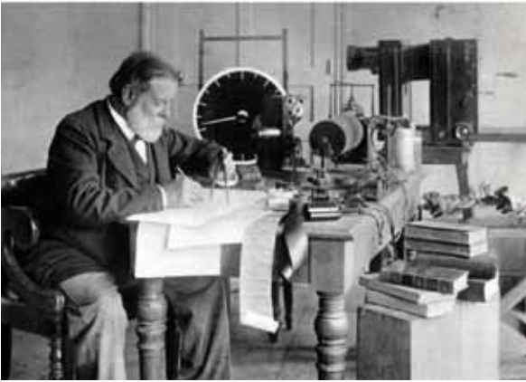
Figuur 2. Via de sphygmomanometer van Marey werden de bewegingen van de perifere puls overgebracht op een kwikkolom en vervolgens op een schrijver die de bewegingen registreerde op beroet papier dat op een draaiende trommel was gemonteerd.
