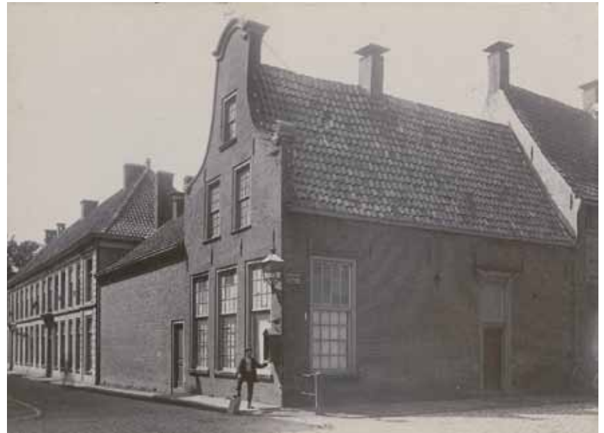
Gevel van het Algemeen Provinciaal, Stads- en Academisch Ziekenhuis aan de Munnekeholm te Groningen, omstreeks 1900.
