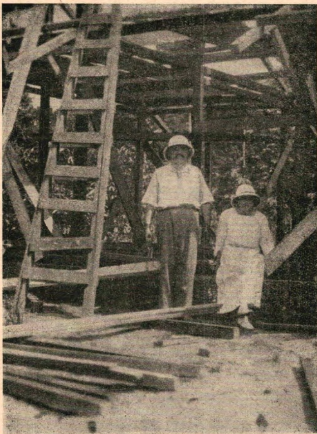
Albert Schweitzer en zijn vrouw bij de bouw van een nieuwe barak in de eerste dagen van het ziekenhuis.
