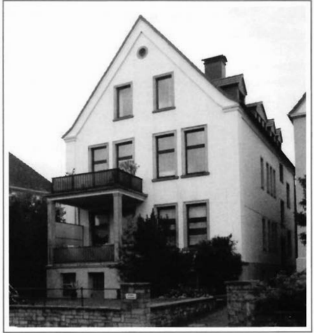
Afb. 15. Huis Ziegelstrasse 9 in Osnabrück
